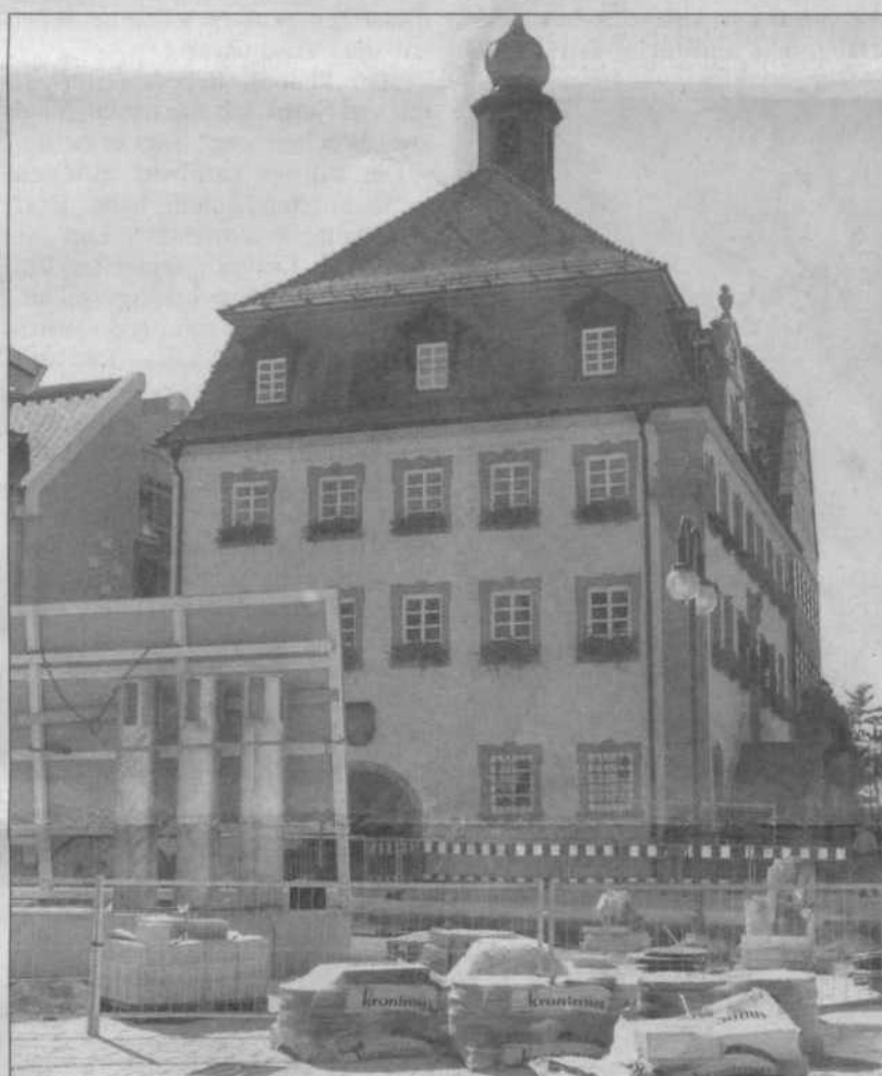
Drei Röhren (links im Bild hinter dem Bauschild) führen dem Bau im Untergrund Luft zu. Sie sollen samt Aufzug durch einen Glasbau kaschirt werden.
